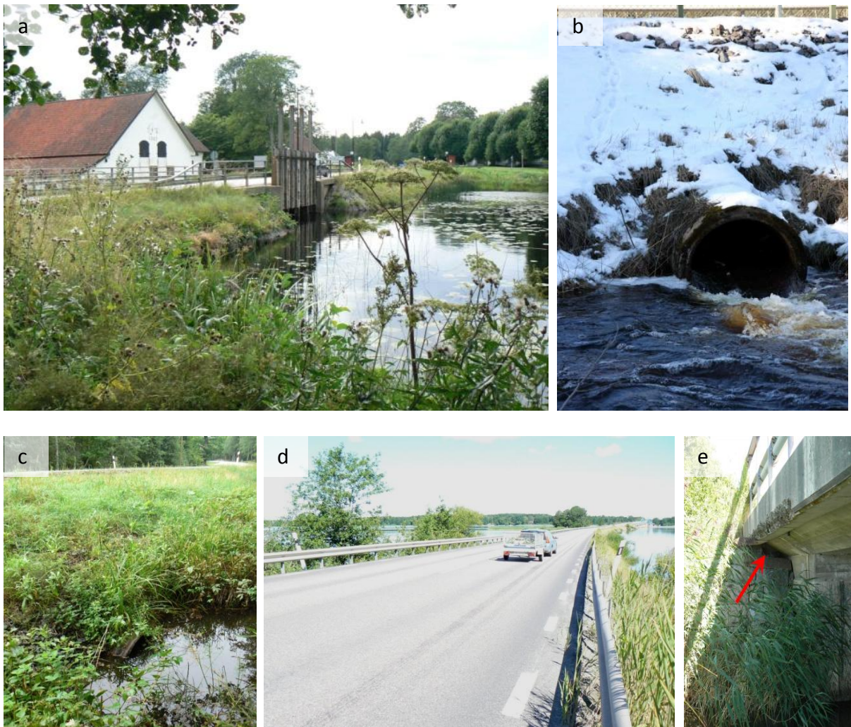
Figur 2. a) Exempel på dammreglering i samband med en bro, b) vägtrumma med hög strömningshastighet, c) översvämmad vägtrumma (bilden är tagen vid lågvatten), d) vägbank tvärs sjö med bro i ena kanten, e) markeringsplats under kantbalken. Foto: J Arrendal, MyraNatur.
